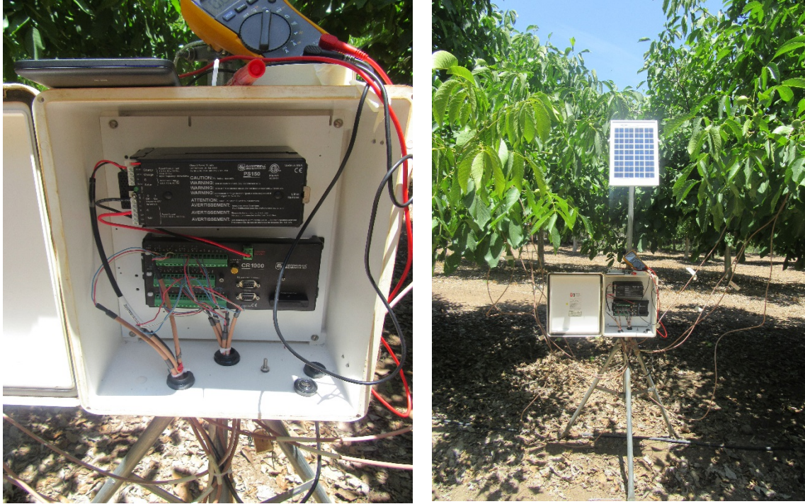
Figura 70. (Izquierda) Datalogger Campbell que permite el registro de datos continuos. (Derecha) Estación de monitoreo energizado con panel solar.
